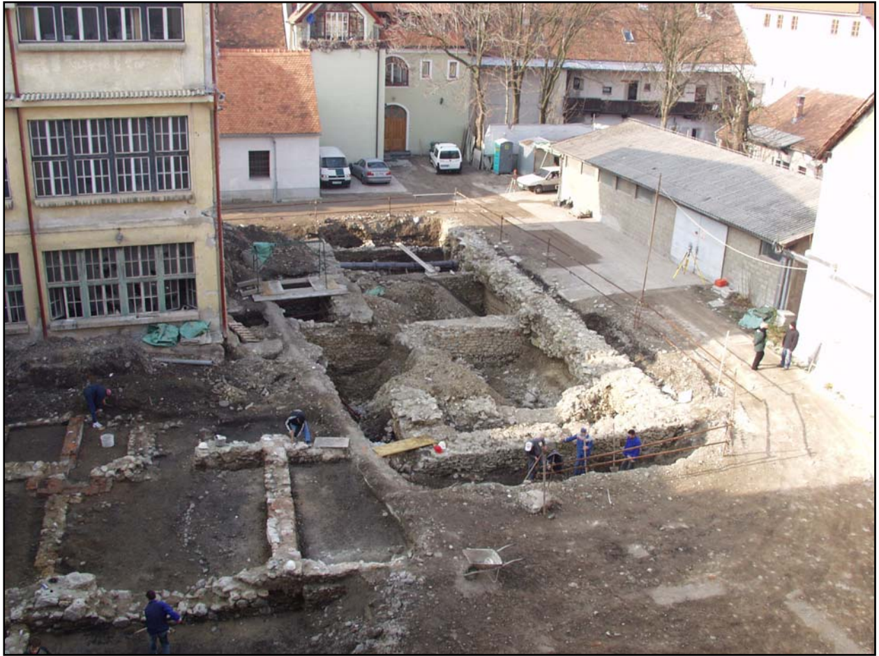
Sl. 2: Pogled na prostor raziskav med izvajanjem del.
